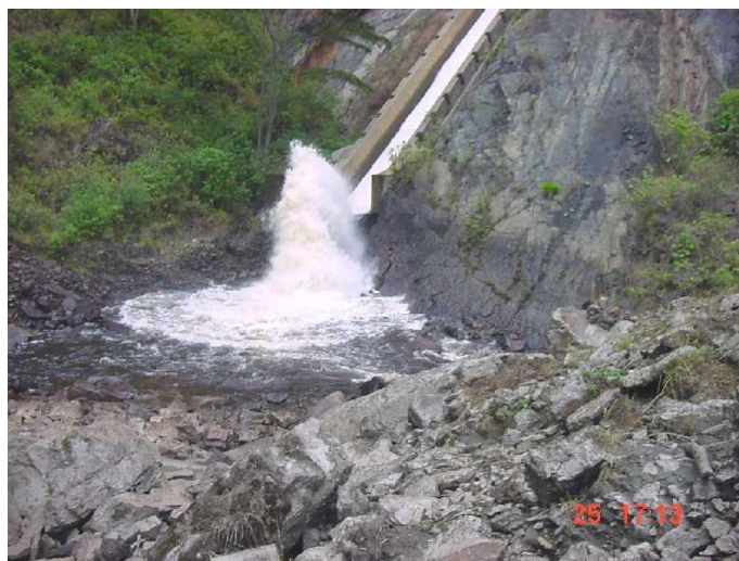
Figura 16. Deflector en la entrega del Tunjita
