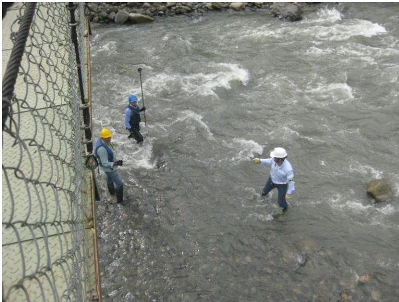
Figura 2.7 Río Bata – Puente Yopo, levantamiento topográfico sección transversal en el cauce.
